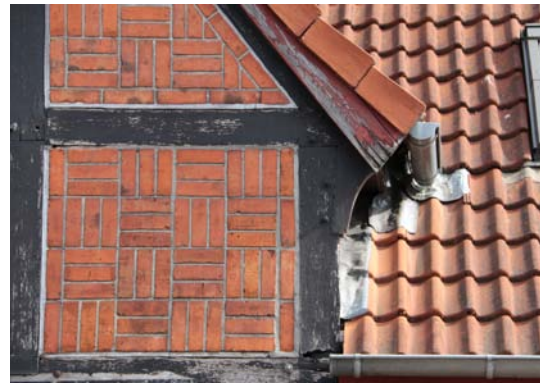
ABB 29: Fachwerk mit Ziegelausfachung
