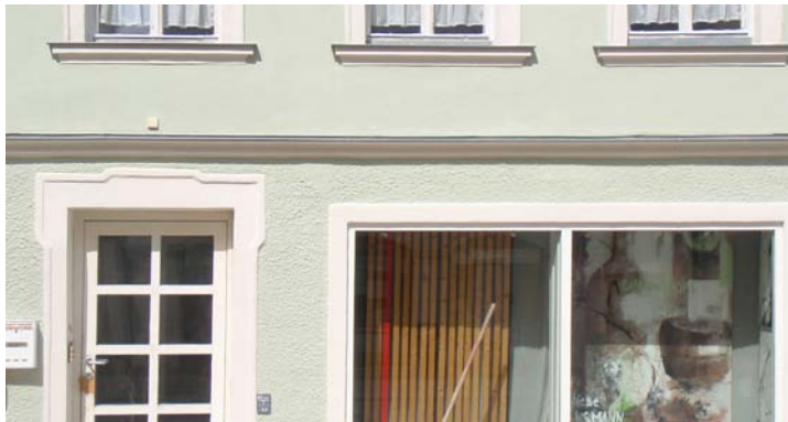
ABB 32: Horizontalgesims gliedert die Fassade und verstärkt die Plastizität
