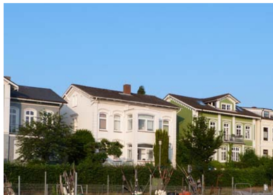
ABB 16: Bebauung am Hafensteig mit schwarzer Dacheindeckung als Ausnahme
