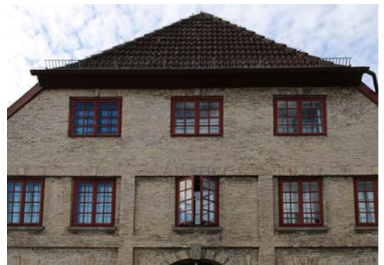
ABB 59: Absetzung von Fenstern durch kräftigere Farbgebung gegenüber der Fassade
