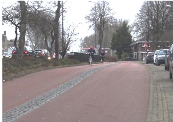
Abbildung 24: Beispiel aufgepflasterten Mittelstreifens
