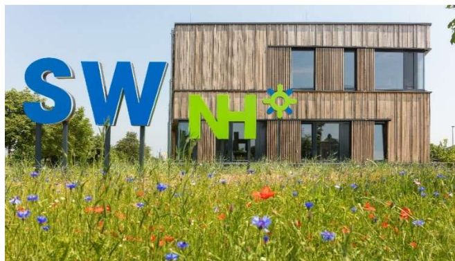
Abbildung 5: Ansicht des neuen Stadtwerkegebäudes
