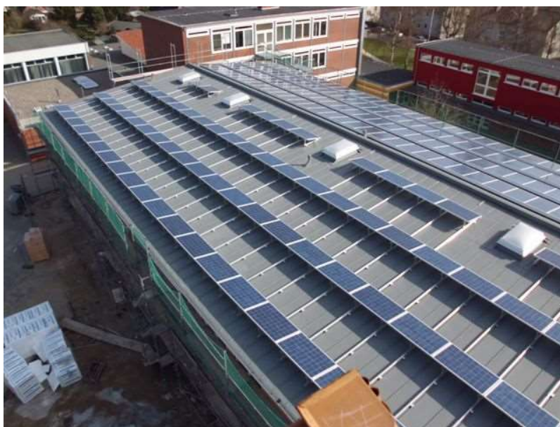
Abbildung 3: Dachfläche der Grundschule Neustädter Bucht www. buergersolar-neustadt.de
