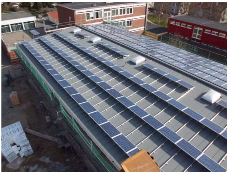
Abbildung 6: Dachfläche der Grundschule Neustädter Bucht www. buergersolar-neustadt.de
